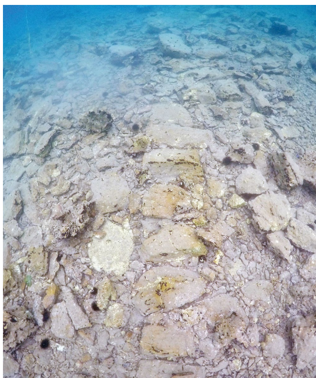
Slika 57. Podvodna snimka s vidljivim suhozidom unutar strukture nasipa (snimio: M. Parica)
