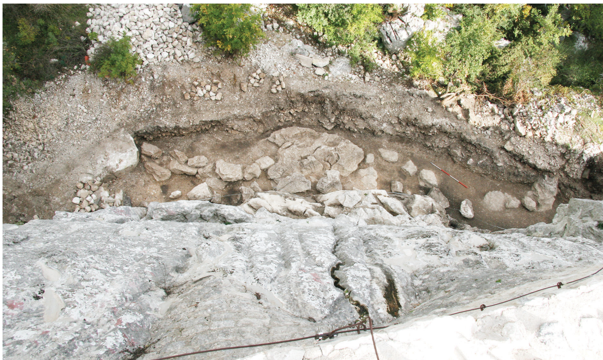
SLIKA 4. Pogled na sondu 1; gromade upale tijekom potresa, 2013. (foto: N. Topić, Omega engineering d.o.o. Dubrovnik).
